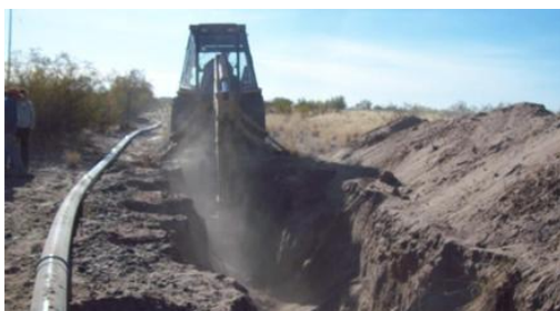
Figura 1: Etapa de construcción del acueducto. Fuente: Archivo Municipalidad de Lavalle
