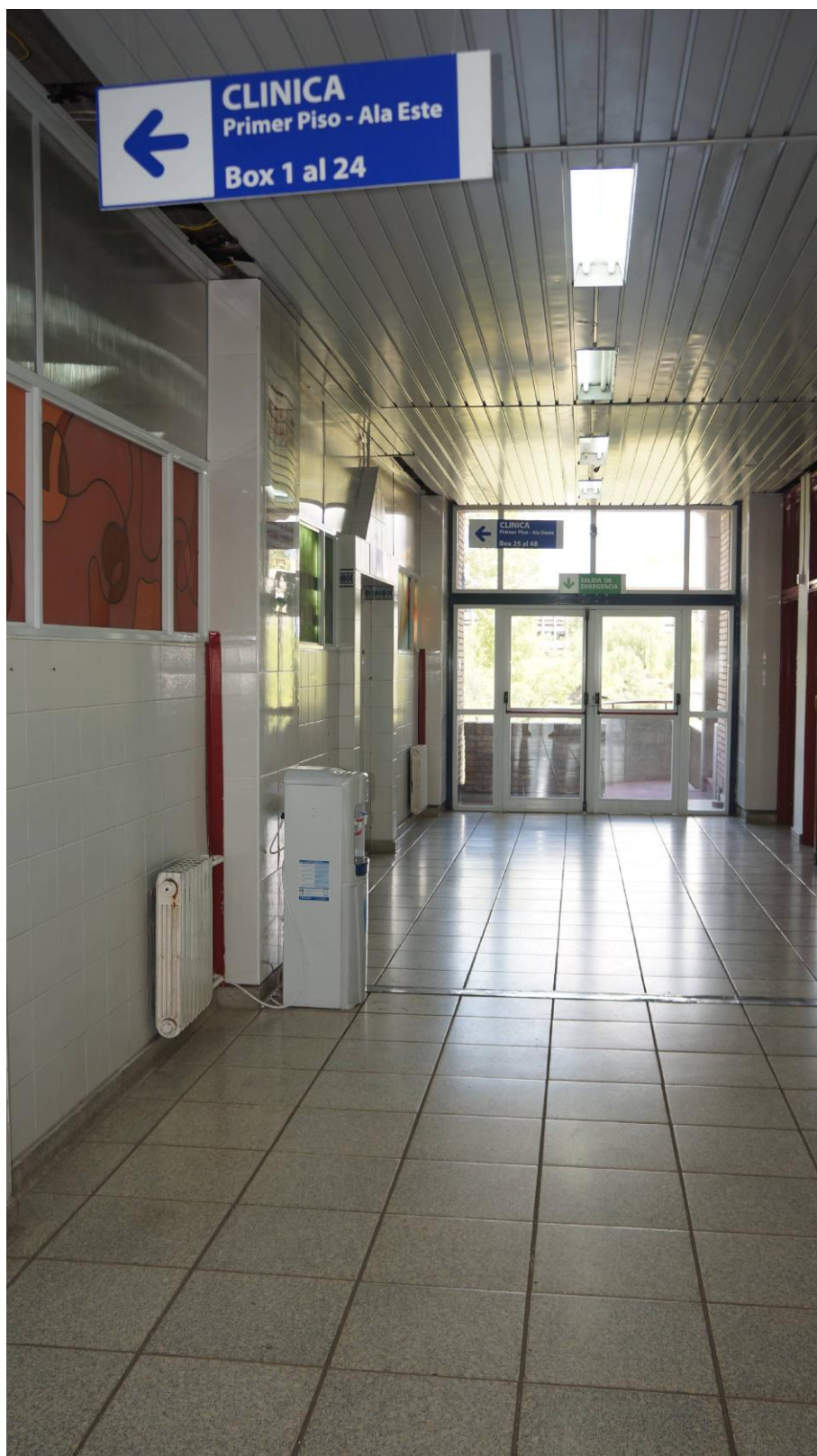
Pasillo acceso y salidas de emergencia con cerramientos metálicos con barrales antipánico
