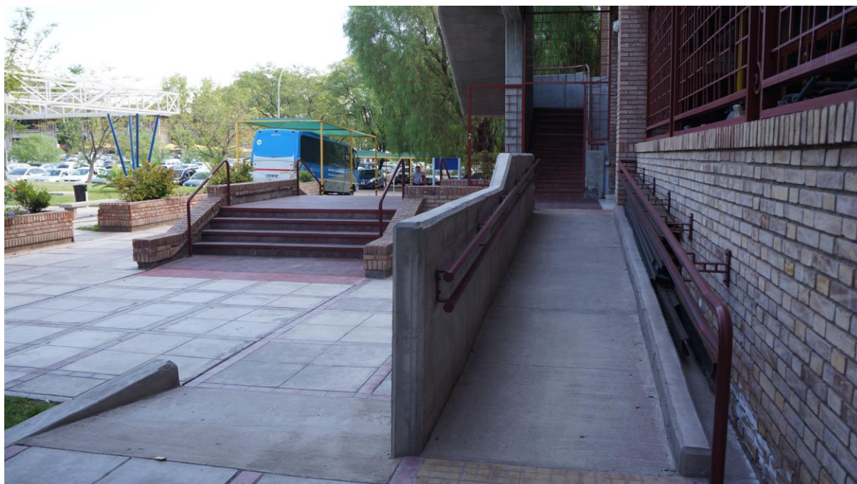
Rampa para acceso a personas discapacitadas y/o con movilidad reducida
