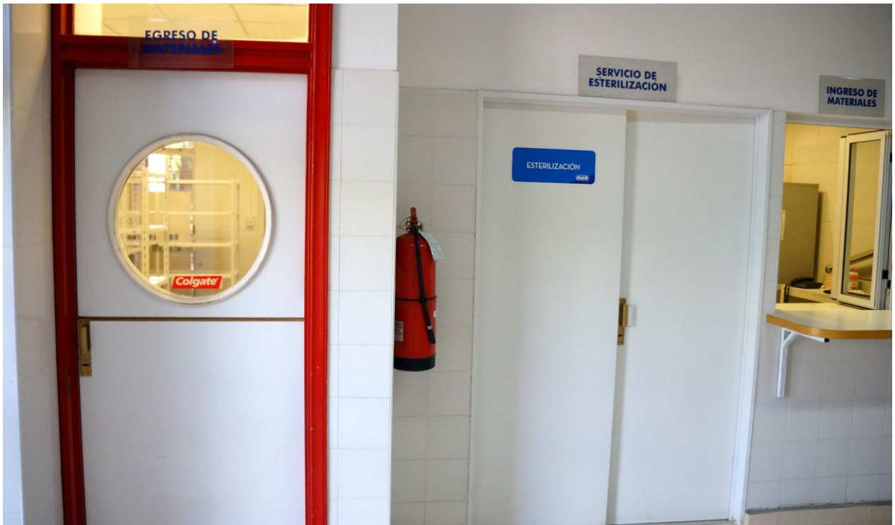
Delimitación Zona de Esterilización. Diferenciación de área de ingreso y egreso de materiales
